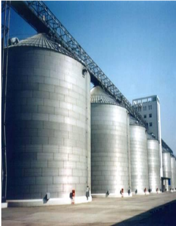
fabricated steel silo 现场组装式
